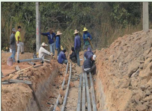
รูปที่ 2 - 1 การขุดหรือย้ายสาธารณูปโภค
