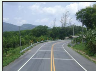
รูปที่ 7-14 สีที่ทาถนนผิวจราจรจะต้องคงอยู่ และสะท้อนแสงได้ดีภายใต้สภาพการจราจรปกติ ไม่น้อยกว่า 24 เดือน
