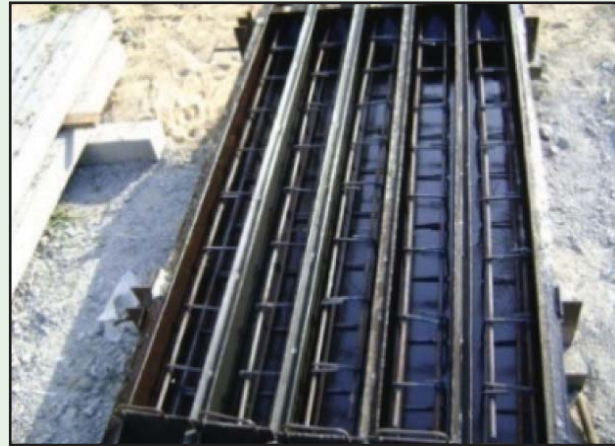
ตรวจสอบแบบหล่อ
