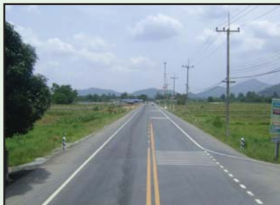
รูปที่ 7-14 สีที่ทาถนนผิวจราจรจะต้องคงอยู่ และสะท้อนแสงได้ดีภายใต้สภาพการจราจรปกติ ไม่น้อยกว่า 24 เดือน
