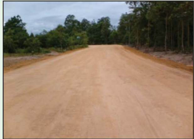
รูปที่ 4-41 ลักษณะของชั้นรองพื้นทางที่แล้วเสร็จต้องเรียบได้ระดับ และความแน่นตามข้อกำหนด
