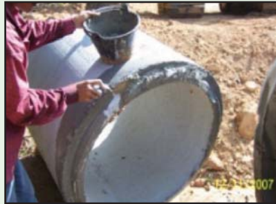
รูปที่ 5-12 การสอปูนภายในปากท่อในขณะวาง
