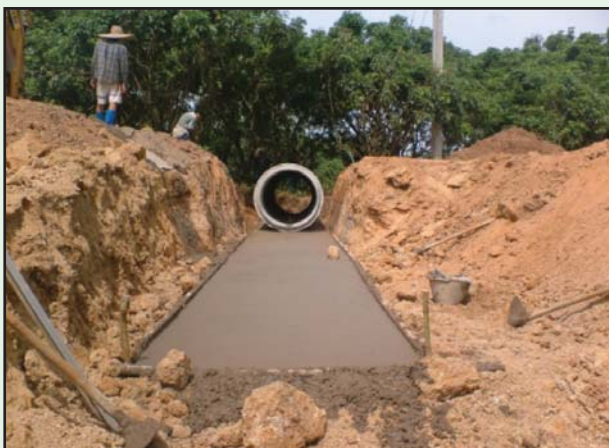
รูปที่ 5-11 เทคอนกรีตหยาบรองรับท่อ
