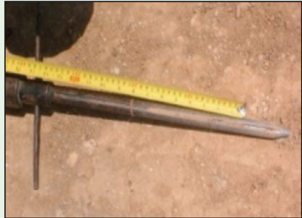
รูปที่ 4-35 การใช้เหล็กเจาะ เพื่อตรวจสอบความหนาแน่นวัสดุ
