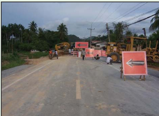
รูปที่ 5-19 แสดงการติดป้ายเตือนและไฟฟ้าแสงสว่างที่บริเวณก่อสร้าง
