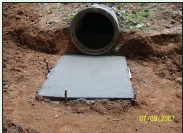
รูปที่ 5-11 เทคอนกรีตหยาบรองรับท่อ
