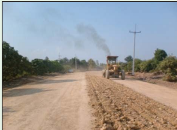
รูปที่ 4-34 การขุดคุ้ยวัสดุ (Scarify) เพื่อทำการบดอัดใหม่ ในกรณีความแน่นไม่ผ่านเกณฑ์
